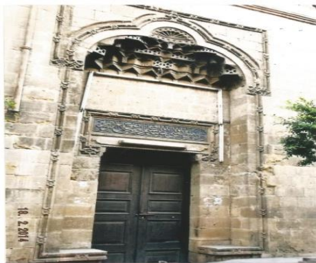
لوحة (٦): المدخل الثاني بالواجهة الغربية والمؤدي الى صحن المسجد والفوارة
