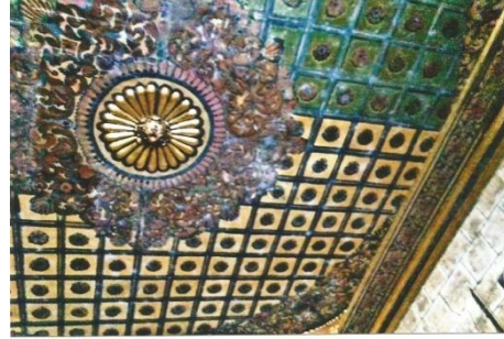
لوحة (٣٧): سقف دركاة المدخل الغربي والتي تسبق الدخول للمسجد
