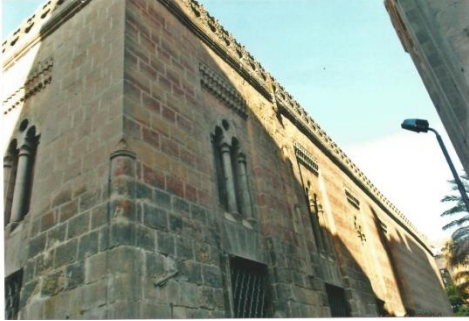
لوحة (٨): الواجهة الجنوبية.
